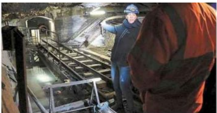
Le local technique abrite la cuve de stockage des 10 m 3 d'eau pompés chaque jour, le système de ventilation et le chargeur de batterie. Photo: CD - Marie-Hélène MORON
