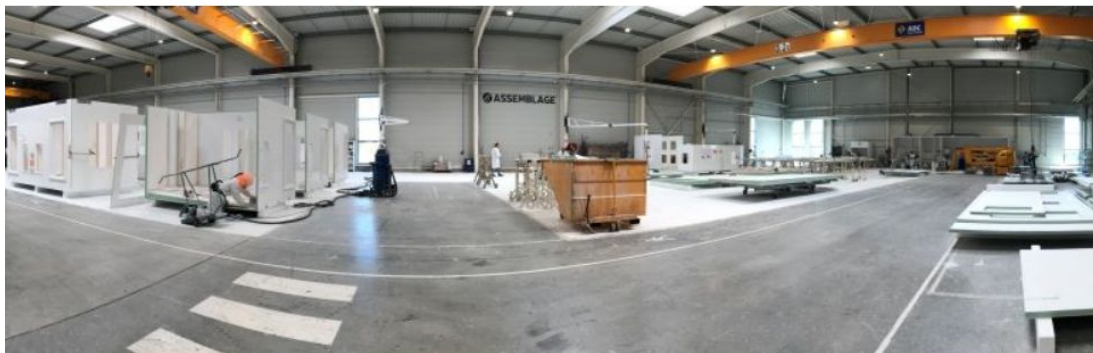
Usine Sodistra Crédit photo : Anne Herbert
