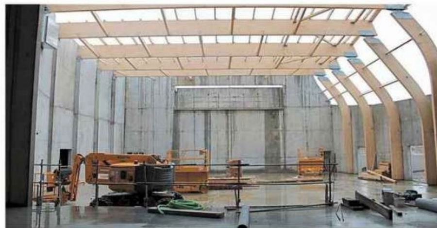
Une vue depuis la scène, de ce que seront les futurs gradins de la salle de spectacles intercommunale. (Photo: Ouest-France)
