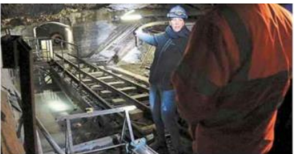
Le local technique abrite la cuve de stockage des 10 m 3 d'eau pompés chaque jour, le système de ventilation et le chargeur de batterie.
