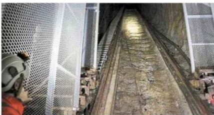
La pente à 37 % de l'ancienne descenderie s'étend sur 207 mètres jusqu'à l'air libre : à gauche les marches, à droite les rails du funiculaire.
