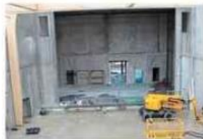
Une vue depuis le futur balcon de la rigole technique, de la scène et des gradins en contrebas. PHOTO : QUEST-FRANCE
