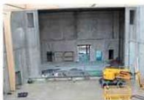
Une vue depuis le futur balcon de la rigie technique, de la scène et des gradins en contrebas. (Photo: Ouest-France)
