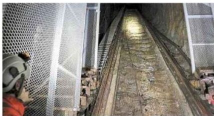
La pente à 37 % de l'ancienne descenderie s'étend sur 207 mètres jusqu'à l'air libre : à gauche les marches, à droite les rails du funiculaire. Photo: CD - Marie-Hélène MORON
